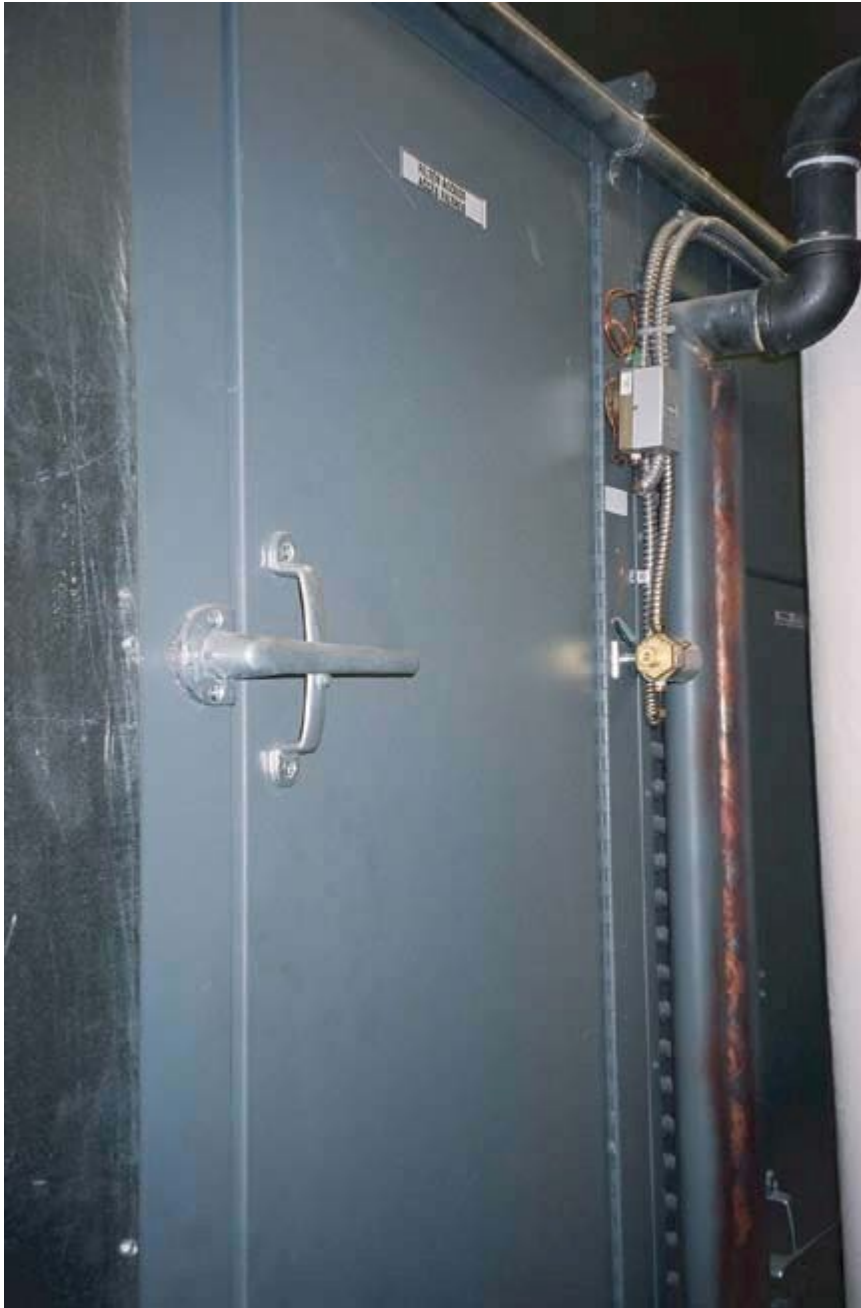
Photographie 3 : Panneau d'accès à un groupe de traitement de l'air – espace restreint
