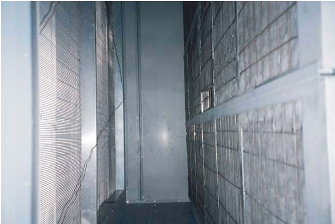
Photographie 4 : Intérieur d'un groupe de traitement de l'air pour lequel les filtres sont changés – espace restreint
